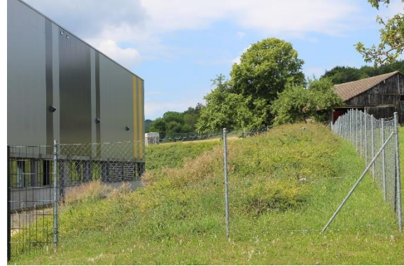
Nördlicher Rand des Betriebsgebäudes mit angrenzend der mit Bodendeckern bewachsenen Böschung.
