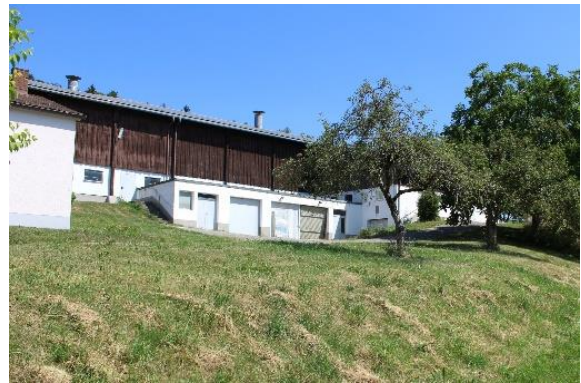
Blick von der Ledergasse auf das nordöstliche Gebäude der Hofstelle. Entlang der Straße sind eine Fettwiese sowie die Bäume Nr. 15 - 17 zu sehen.
